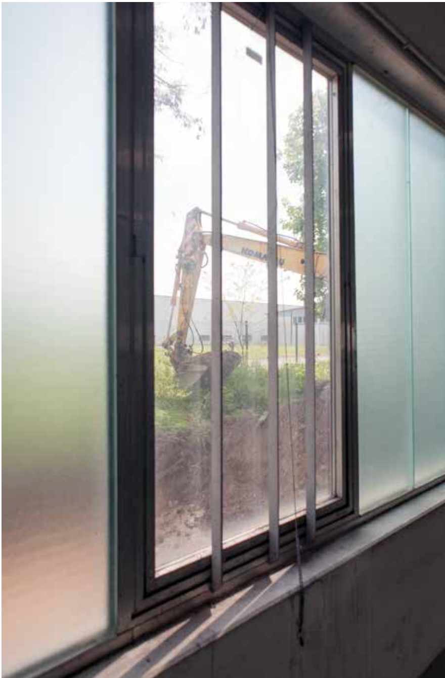
Erste Vorarbeiten für die Betriebstechnik: Der externe Trafo braucht ein Fundament.
