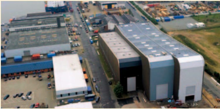
Abb. 2 Die 70 m und 90 m langen Testhallen wurden in der Nähe des Hafenbeckens errichtet, um die Anlieferung per Schiff zu vereinfachen. Quelle: Fraunhofer IWES
