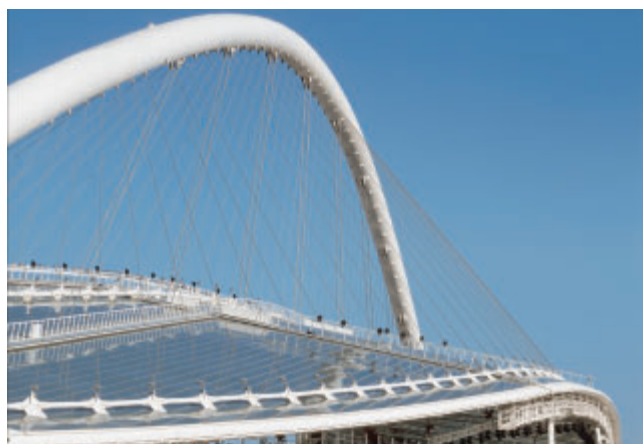
Transparente Leichtbaudachkonstruktionen auf Polycarbonatbasis (Quelle: Bayer MaterialScience AG)
