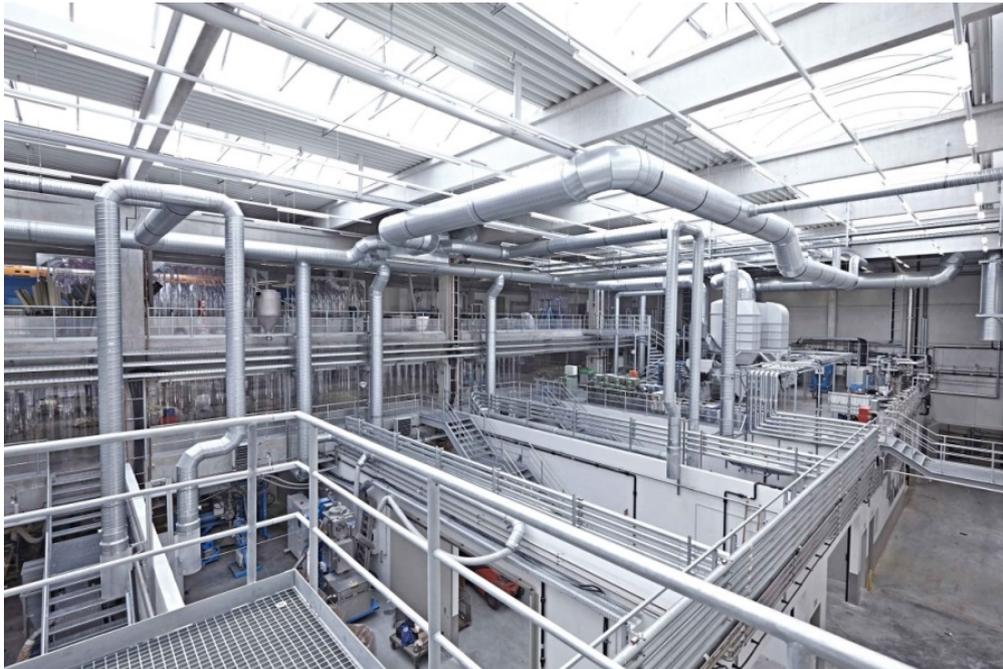
*Das neue Technikum in Stuttgart umfasst abgetrennte Versuchsräume im Erdgeschoss sowie die Dosierebene im 1. und die Produktbereitstellung im 2. Geschoss
